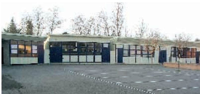
Réfection des peintures extérieures de 7 préfabriqués
