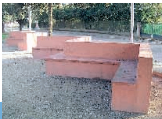
Réfection des bancs, au terrain de pétanque
