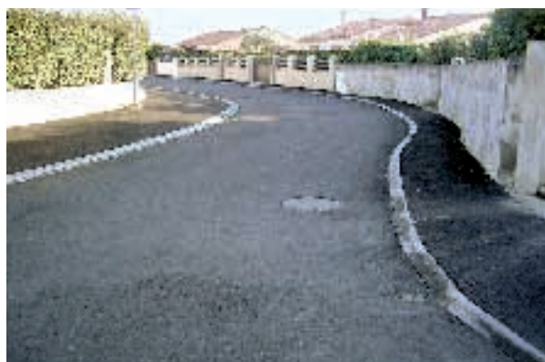
Élargissement de la rue François Verdier (lotissement Bourrassol)
