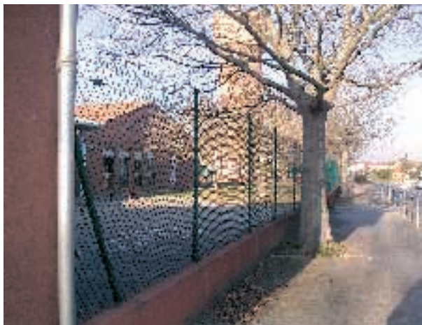
Réfection du grillage de la cour (maternelle)
