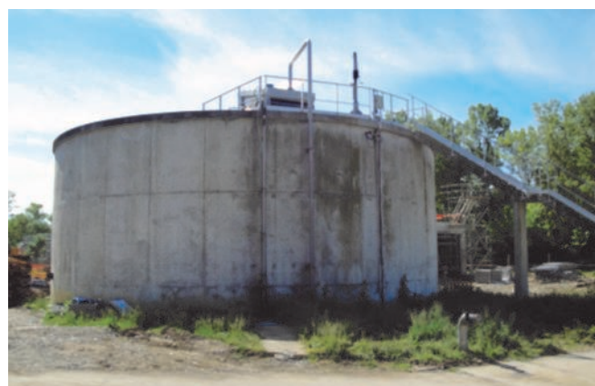
Le silo à boue
