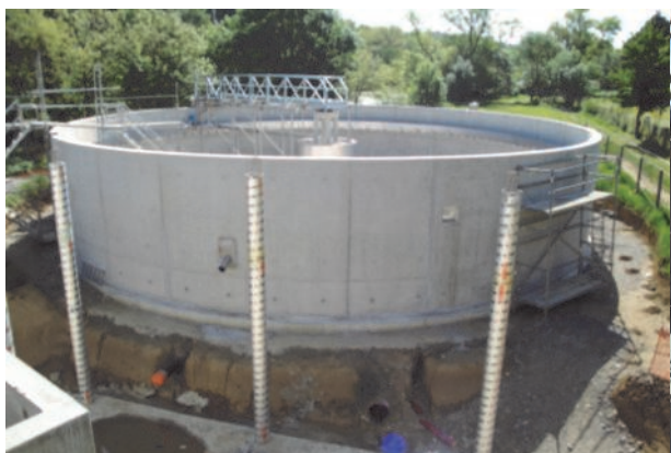
Le nouveau décanteur
