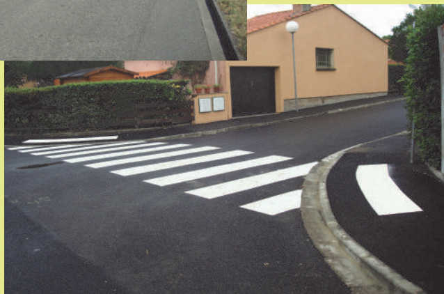
Mise en accessibilité des trottoirs
