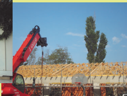
Pose de la charpente
