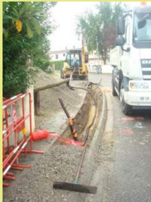
Rénovation éclairage au lotissement des tuileries
