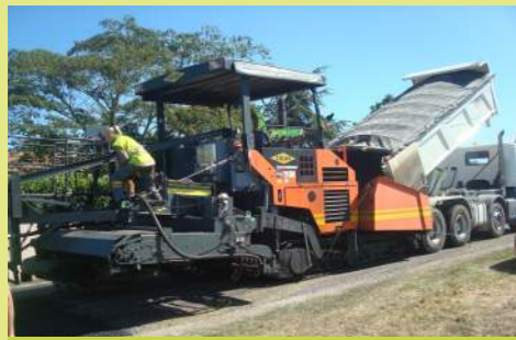
Nouvelle technique de goudronnage
