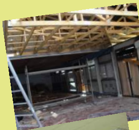
Rénovation aux Ecoles (toiture et classes)
