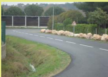
Rénovation Impasse des Lilas
