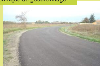
Rénovation chaussée du chemin de LESPALLIERE
