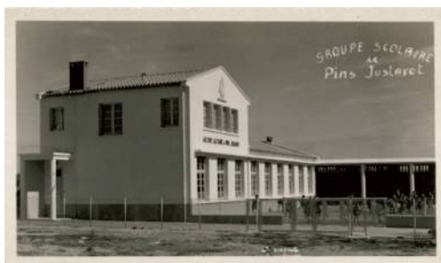
Groupe Scolaire - avenue de Toulouse
