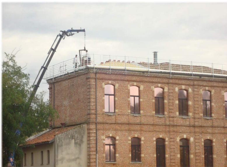
Rénovation du toit de la Mairie
