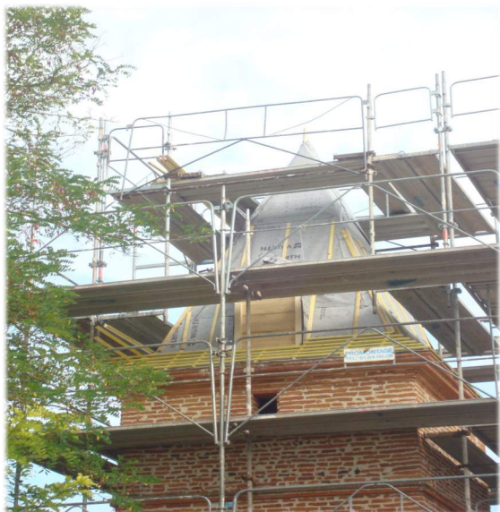
Rénovation du toit du pigeonnier
