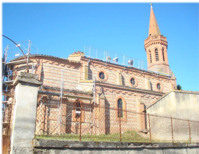
Rénovation de la toiture de l'Eglise
