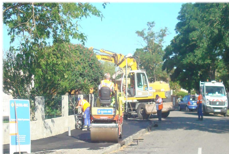
Rénovation des trottoirs du lotissement du Château
