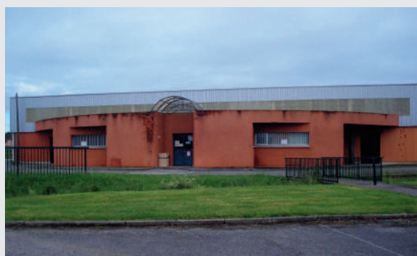
Halle des sports avant travaux
