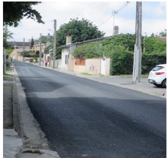
Réfection de la chaussée rue de la Bourdasse
