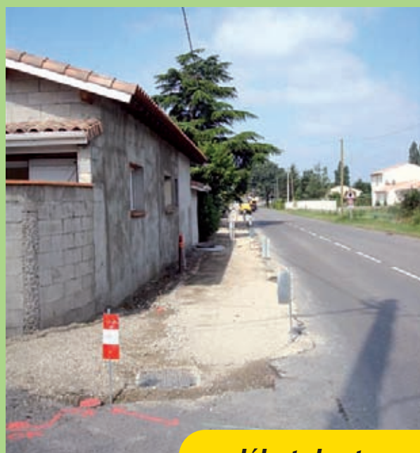
... début des travaux
