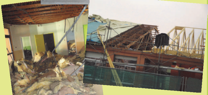
Travaux de réfection de la toiture du Groupe Scolaire
