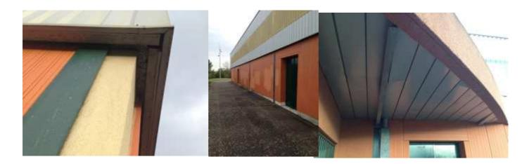
Couverture existante vieillissante et éclairage naturel détérioré. Charpente existante conservée avec protection et remise en peinture. Conservation des lanterneaux de désenfumage et du système adapté au châssis.
