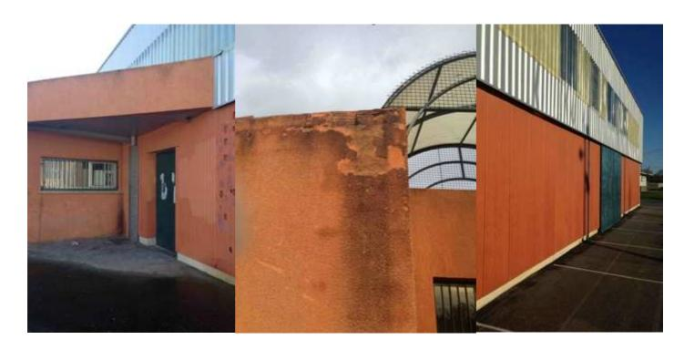
Composition du bardage sur la partie supérieure ainsi que faux plafond extérieur en tôle.
