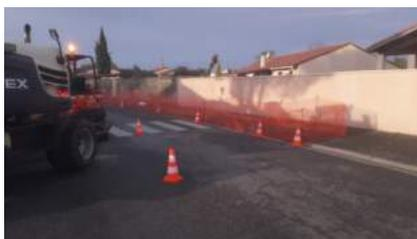
Dans le cadre d'un plan global de mise en accessibilité progressive de son réseau, TISSEO a missionné le Muretain Agglo pour assurer la mise en conformité des arrêts de bus situés chemin du Cros. Ces travaux qui ont nécessité la dépose puis la repose de l'arrêt de bus se sont déroulés ce mois de novembre et sont pris en charge financièrement par TISSEO. Une intervention plus légère a été faite sur l'arrêt de bus situé avenue de Pinsaguel à l'angle de la route de Lacroix-Falgarde.
